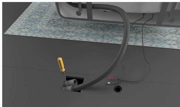
**15.** Passer le fil de chromothérapie et le fil de détection d'humidité dans le second conduit pour les rendre à l'emplacement du souffleur.
