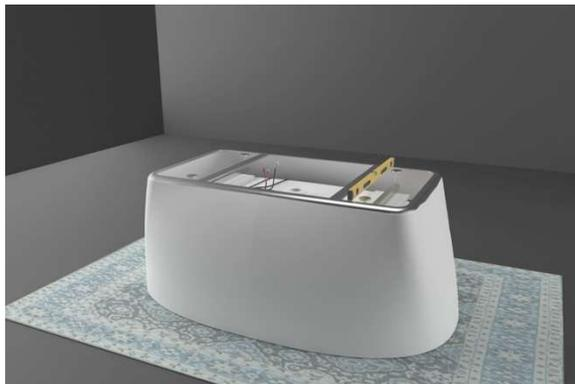
**10.** Marquer l'emplacement du drain, percer le plancher pour accueillir les conduits pour le drain, l'air chaud et les connexions au souffleur.
