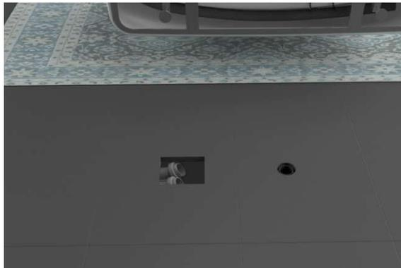
**11.** Sélectionner un endroit à proximité pour l'emplacement du souffleur. Cet endroit doit être chauffé, bien ventilé, exempt de tout débris, facilement accessible et localisé à un maximum de 12 pieds de la baignoire (ex : garde-robe, vanité). Le plus près demeure cependant le mieux.
